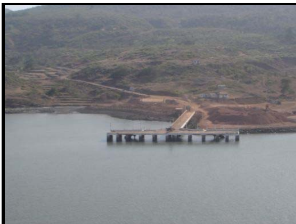
Dighi Port Jetty
